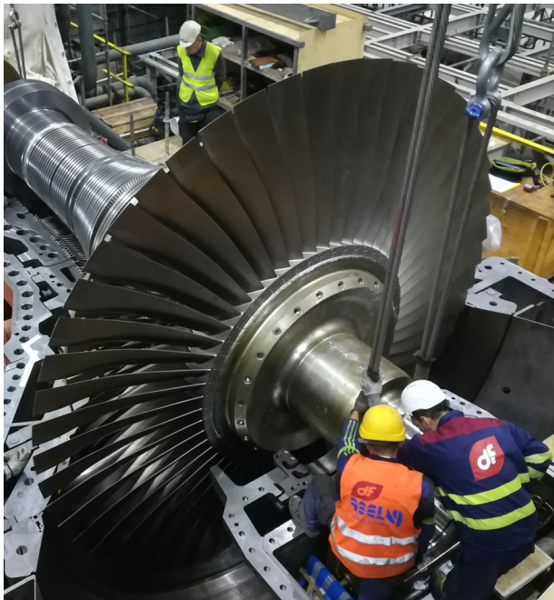
Montaje de la turbina de la central de ciclo combinado de Iernut (Rumanía)
