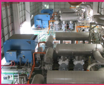
Compresores alternativos HP LP, Fluxys, Bélgica
