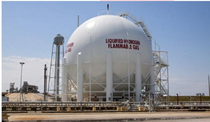
En la plataforma de lanzamiento 39B del Centro Espacial Kennedy de la NASA, tanques esféricos como este han servido de apoyo durante más de 30 años a los lanzamientos del transbordador espacial. Han sido inspeccionados, reacondicionados y pintados para seguir en servicio y servir de apoyo recientemente al cohete Space Launch System (SLS) -el cohete más potente jamás construido por la NASA- y a
