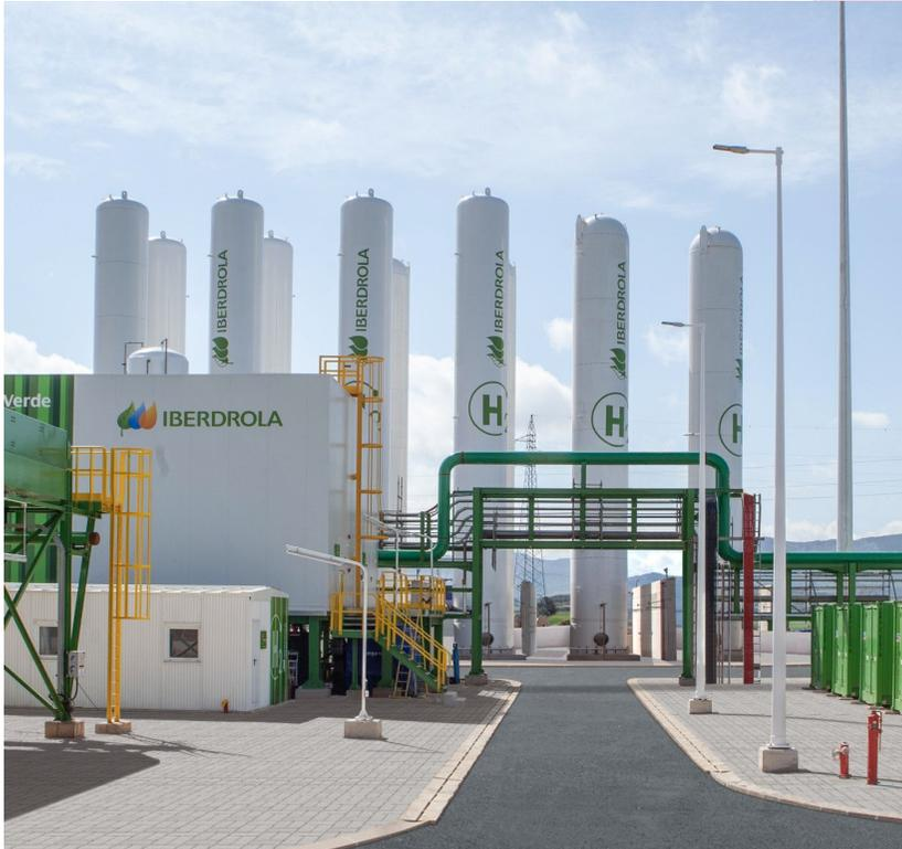
Por ejemplo, cada uno de esos 11 tanques de Iberdrola en su instalación de Puertollano puede almacenar  $133\text{m}^3$  de  $\text{H}_2$ , miden 23,5 metros de alto y  $2,8\text{m}\varnothing$ , y están fabricados con un acero de 45mm de espesor que les permite soportar 60 bares de presión.
